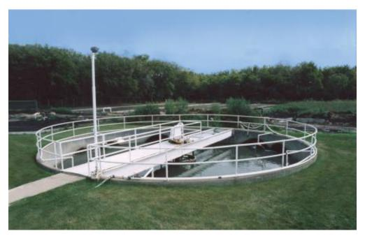
在小型污水处理设施中只有一个沉淀池,了解沉淀池的表面液位是很有必要的。在较大型的污水处理装置中,在渗透水通过分流箱到达许多沉淀池中,分流箱内可能没有足够的空间来容纳液位仪表。在这种情况下,对沉淀池的液位监控将有助于获得适当的负载平衡。
